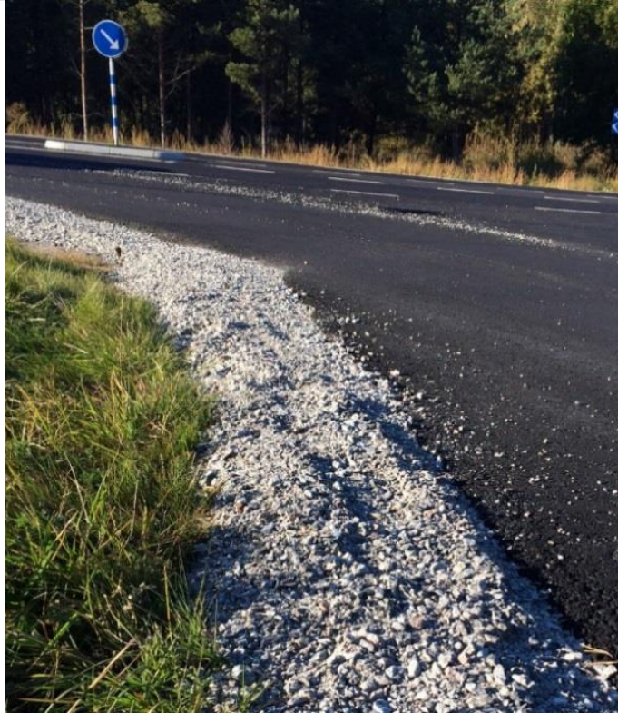
Dåligt utförda stödremсор
