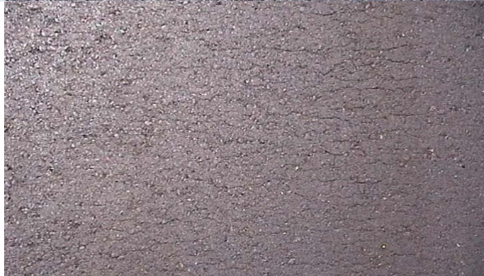
Mikrosprickor p g a dåligt klistrat eller klistrat på dåligt rengjort underlag
