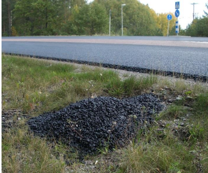
Överblivna asfaltmassor som ej är bortkörda
