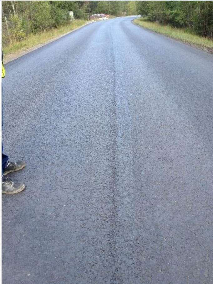
Öppen mittskarv som ej är förseglad
