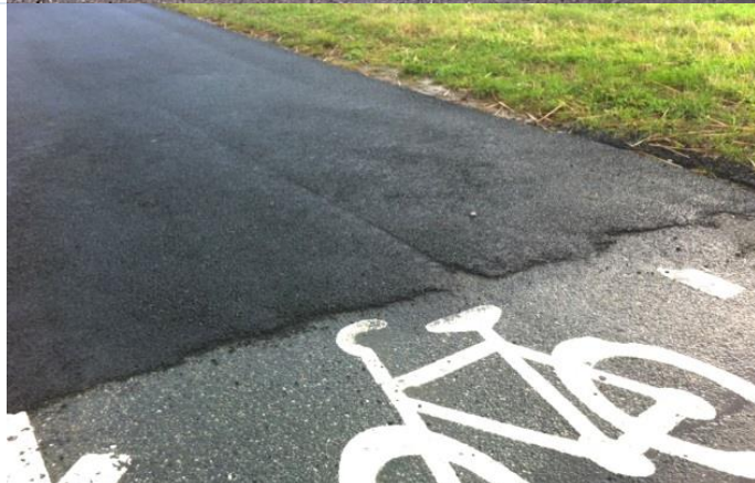
Dåligt utförd skarv
