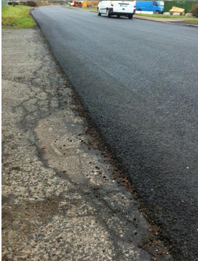
Ej utförd utspetsning mot angränsande ytor
