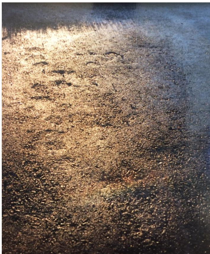
Handlagd yta med dålig packning
