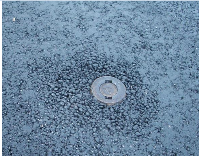
Separation och öppna ytor runt brunn
